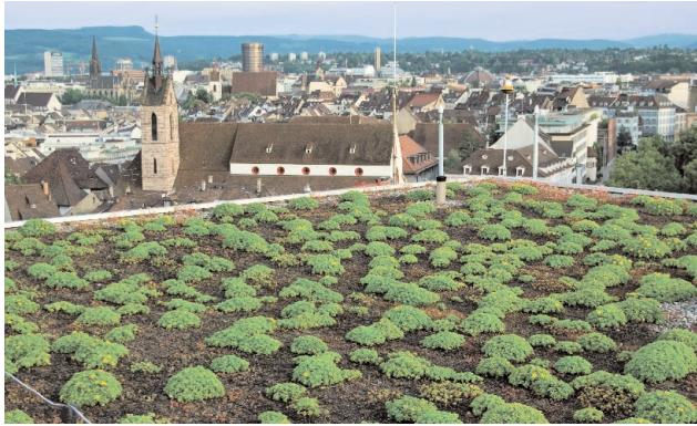
Es kommt nicht auf die Quantität, sondern auf die Qualität von Dachbegrünung an. Oben: Bei dünn-schichtigem Aufbau ist der Bewuchs entsprechend gering. Rechts: Die extensive Dachwiese auf dem Universitätsspital Basel ist stadtoökologisch wesentlich wirksamer.
